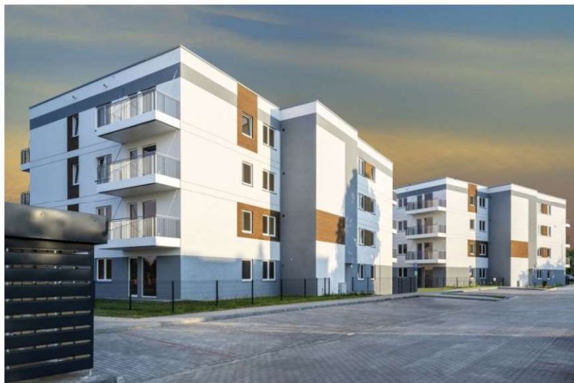
Fot. 1.3 Prefabrykowane domy wielorodzinne o konstrukcji drewnianej, Bielsk Podlaski (fot. Z archiwum Stowarzyszenia Energooszczędne Domy Gotowe)
