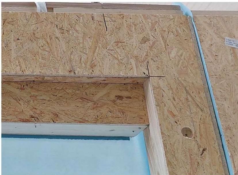
Fot. 5.4 Płyty w narożach powinny być wycinane z zachowaniem kształtu „L” (fot. Z archiwum EDG)
