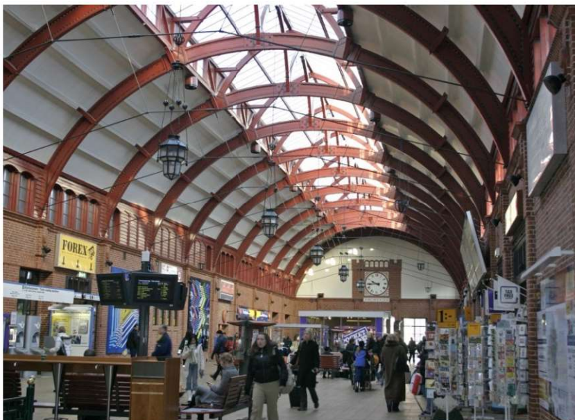
Fot.1.11. Dworzec kolejowy w Malmö, konstrukcja z 1923 r. (fot. E. I. Kotwica)
