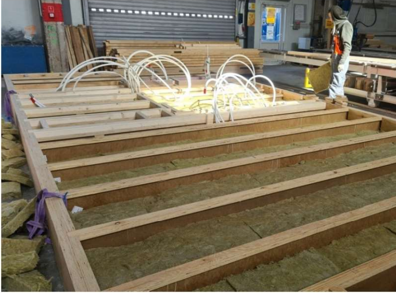
Fot. 1.14 Prefabrykacja stropu o konstrukcji szkieletowej (fot. P. Sulik)
