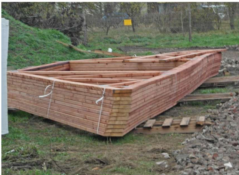
Fot. 7.7 Niepoprawny sposób składowania więzów kratowych – widoczne odkształcenia spowodowane nierównością podparć oraz zbyt bliska odległość od ziemi. (fot. E.I. Kotwica)
