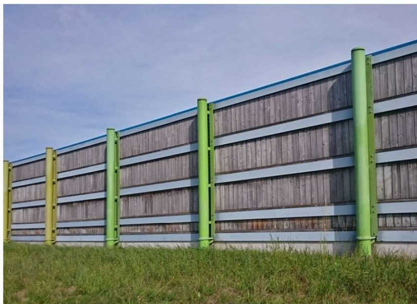
Fot.1.4. Ekrany akustyczne (fot. E. I. Kotwica)
