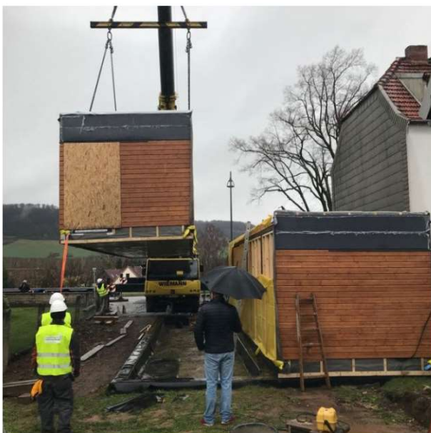
Fot.1.16 Montaż jednorodzinnego budynku modułowego (fot B. Jaworski)
