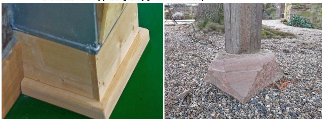
Fot. 7.26 TAK. Wykonstruowując odpowiednio podporę można oddalić konstrukcyjny element drewniany od podłoża, zapobiegając tym samym jego zawilgoceniu. Po lewej stronie podstawę słupa odsunięto od podłoża, obudowując element fundamentu żelbetowego drewnem. Zdjęcie po prawej stronie pokazuje, że wiedzę tę posiadali już dawni mistrzowie budowlani (fot. E. I. Kotwica)
