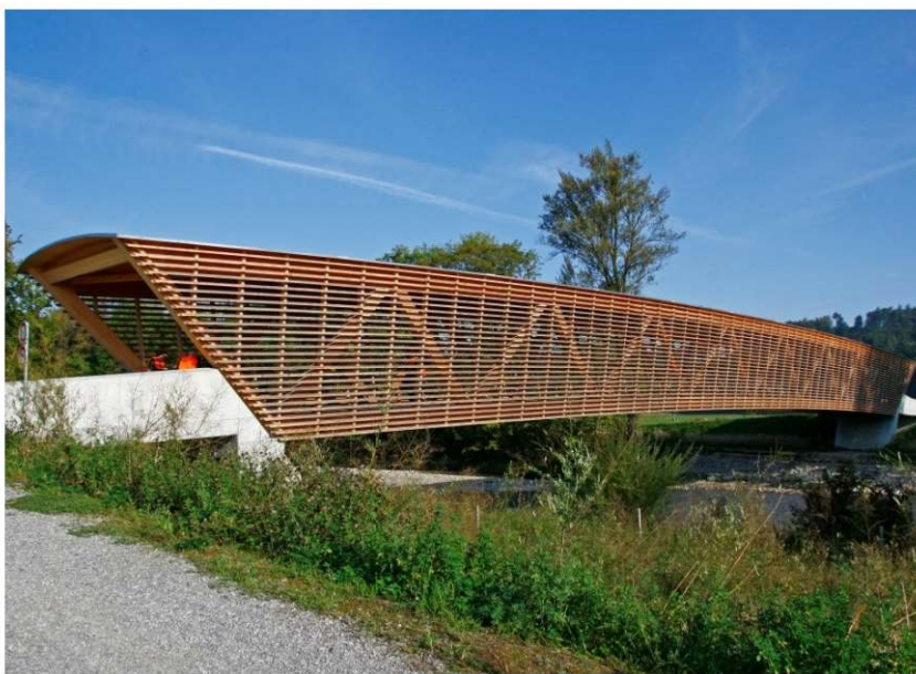
Fot.1.8 Most Neumatt Szwajcaria. Rozpiętość 59 m, 2013 r. (fot. E.I. Kotwica)
