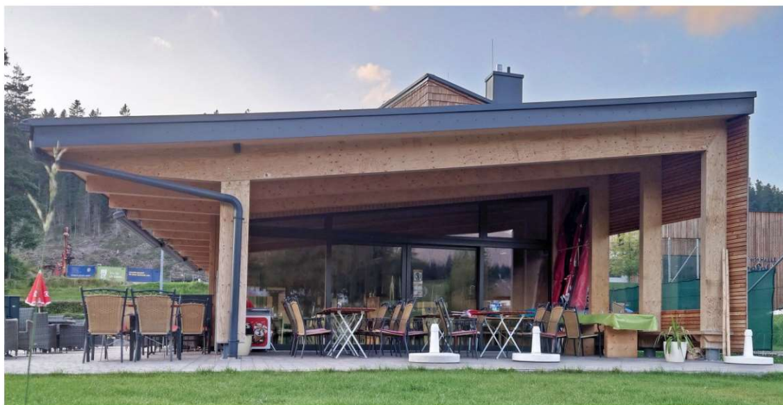
Fot. 2.12 Przykładowe zastosowanie LVL jako konstrukcji nośnej obiektu zaplecza przy kortach tenisowych, Seefeld. (fot. E.I. Kotwica)
