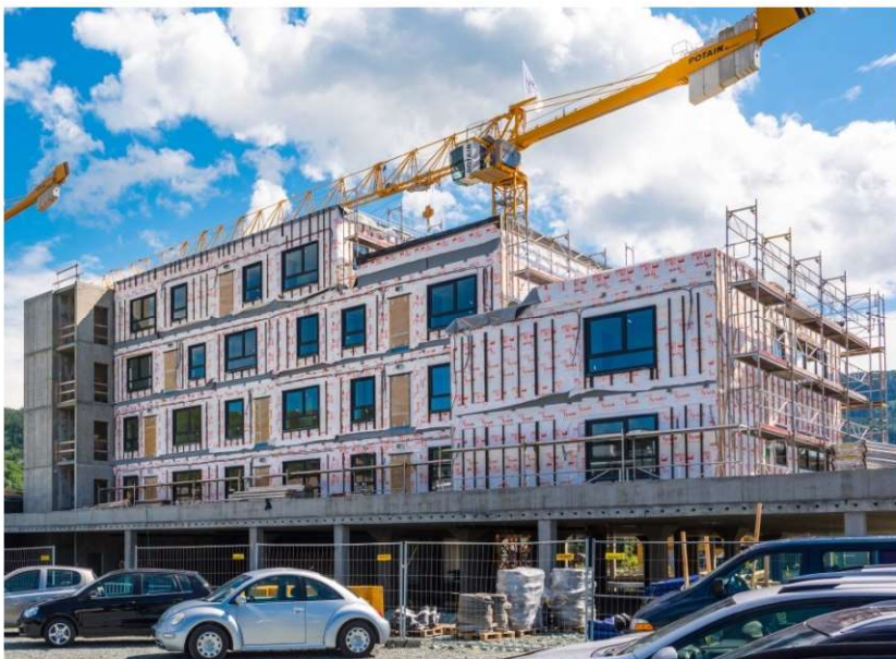
Fot.1.15 Montaż modułowego budynku wielorodzinnego przez polskiego producenta w Norwegii (fot. z archiwum Stowarzyszenia Energooszczędne Domy Gotowe)
