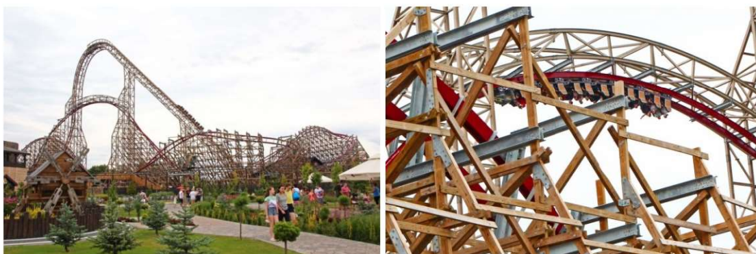
Fot. 2.3 Najwyższy drewniany roller coaster świata – Zadra, znajdujący się w Energylandii w Zatorze – widok ogólny i detale (fot. E.I. Kotwica)
