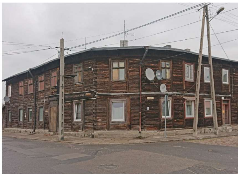
Fot. 1.1 Budynek mieszkalny w Zgierzu z połowy XIX w. (fot. E. I. Kotwica)
