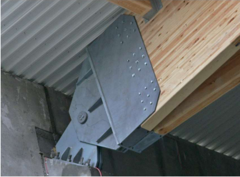
Fot. 4.8 Detal przegubowego węzła podporowego (fot. P.Sulik)
