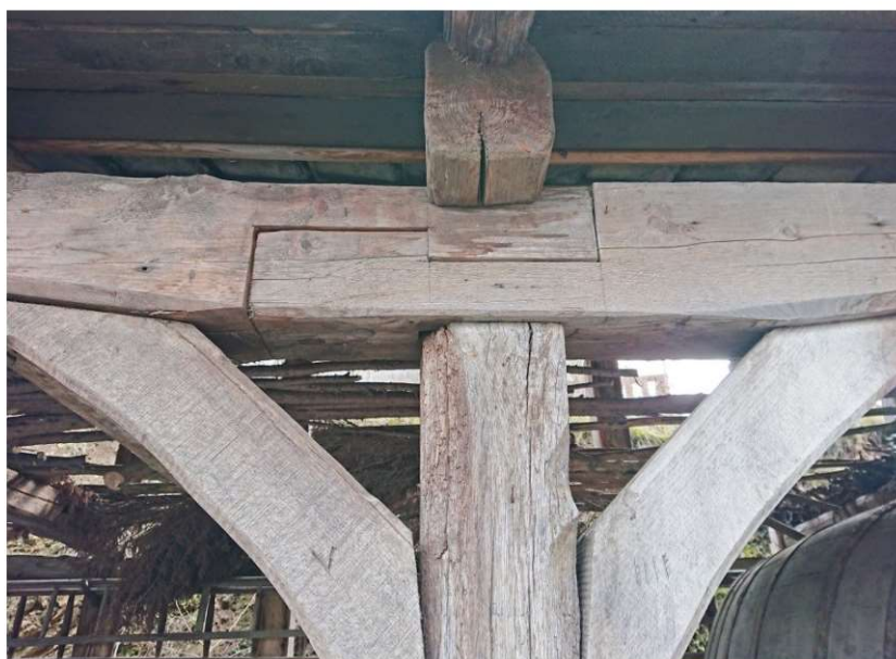
Fot. 4.5 Tradycyjne połączenia ciesielskie (fot. E. I. Kotwica)
