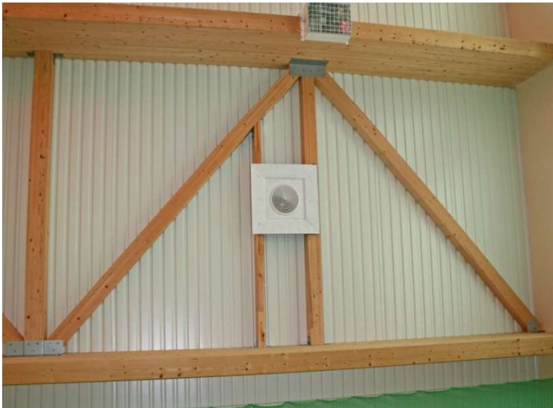
Fot. 4.14 Stężenia wiatrowe drewniane (fot. E. I. Kotwica)
