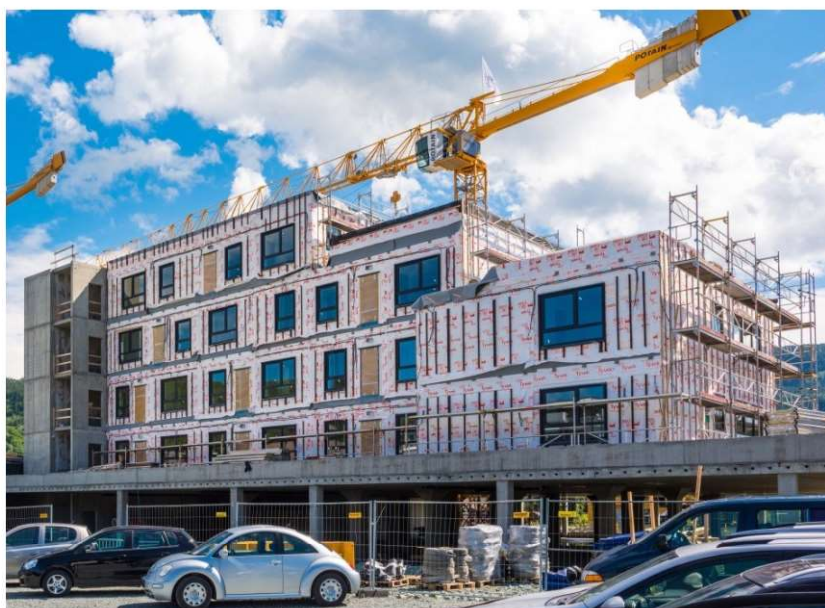
Fot.5.13 Montaż modułowego budynku wielorodzinnego przez polskiego producenta w Norwegii (fot. z archiwum Stowarzyszenia Energooszczędne Domy Gotowe)
