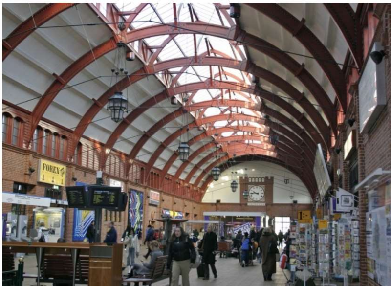
Fot.5.9. Dworzec kolejowy w Malmö, konstrukcja z 1923 r. (fot. E. I. Kotwica)
