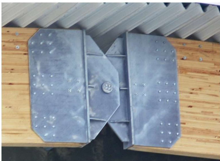
Fot. 7.31 TAK Przegub kalenicowy (fot. P. Sulik)
