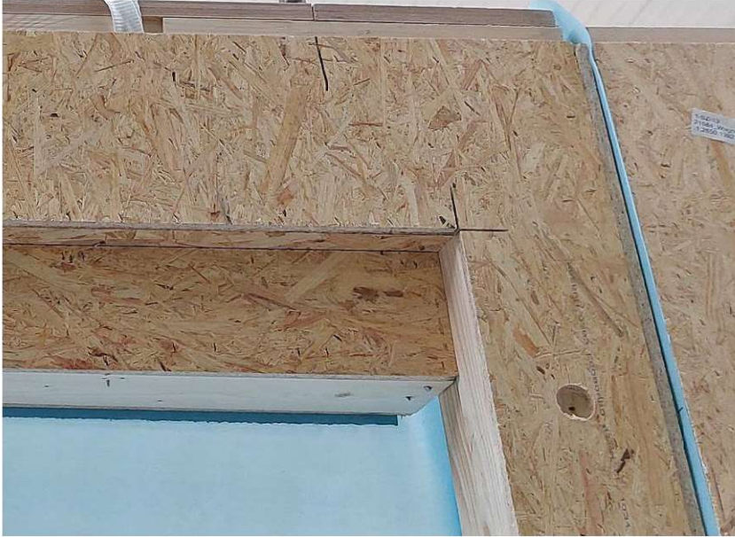
Fot. 4.2 Płyty w narożach powinny być projektowane tak, by zachowany został kształt „L” (fot. z archiwum Stowarzyszenia EDG)
