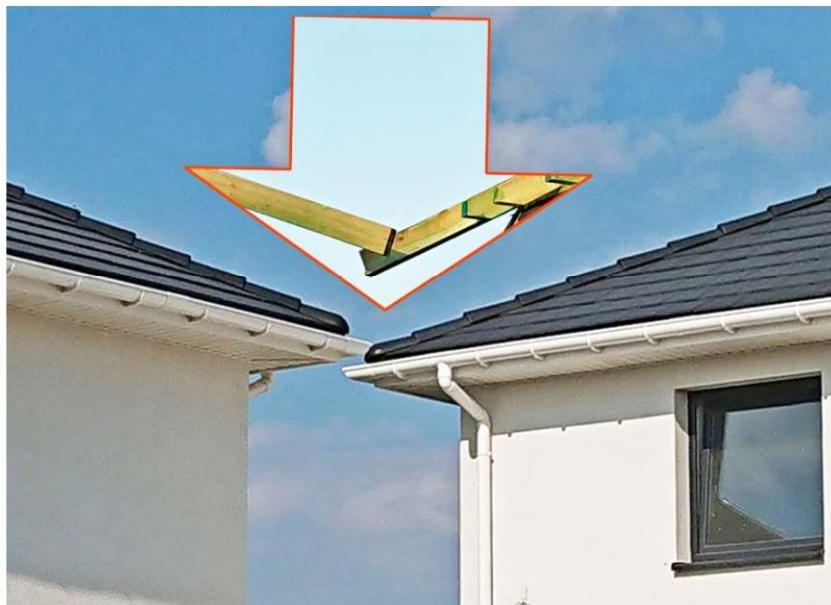
Fot. 7.1 Domy jednorodzinne na jednej działce. Odległość okapów rzędu kilkudziesięciu centymetrów (fot. E.I. Kotwica)
