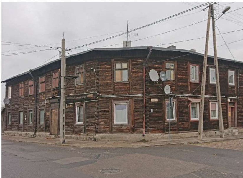
Fot. 1.9 Budynek mieszkalny w Zgierzu z połowy XIX w. (fot. E. I. Kotwica)
