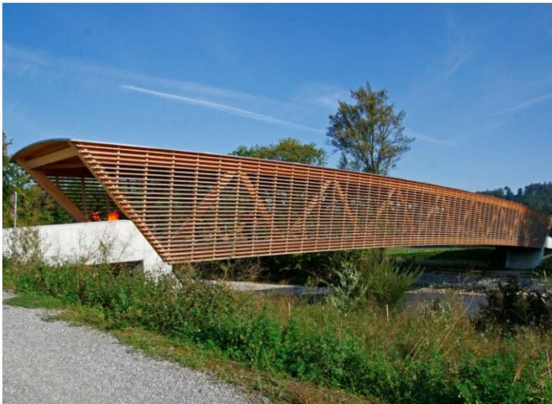
Fot. 5.6 Most Neumatt Szwajcaria. Rozpiętość 59 m, 2013 r. (fot. E.I. Kotwica)
