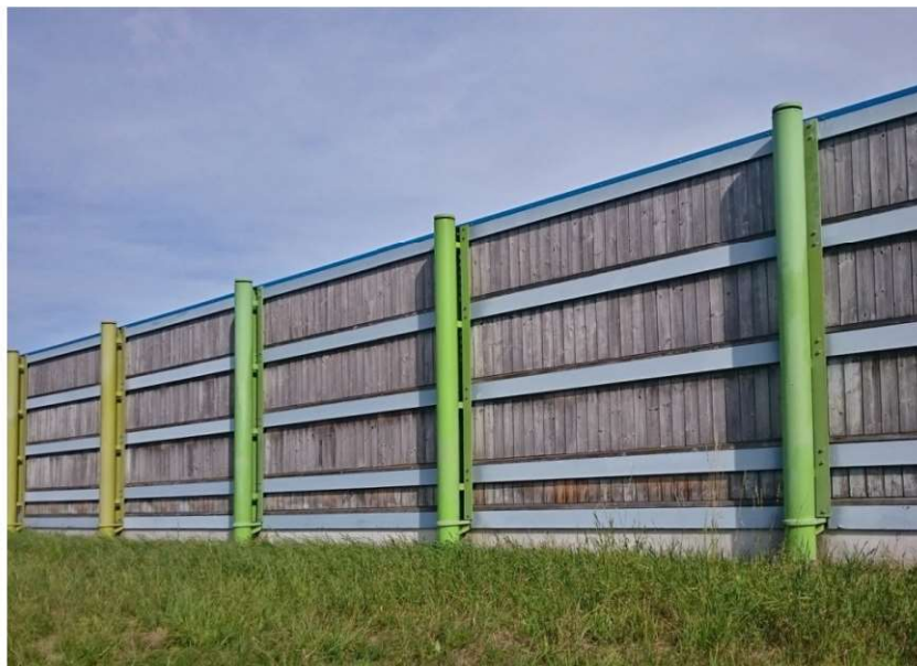
Fot.5.2. Ekrany akustyczne (fot. E. I. Kotwica)
