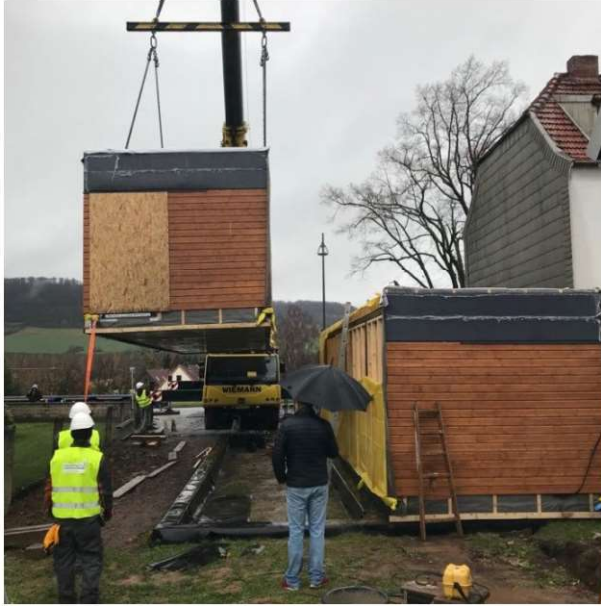
Fot.5.14 Montaż jednorodzinnego budynku modułowego (fot B. Jaworski)
