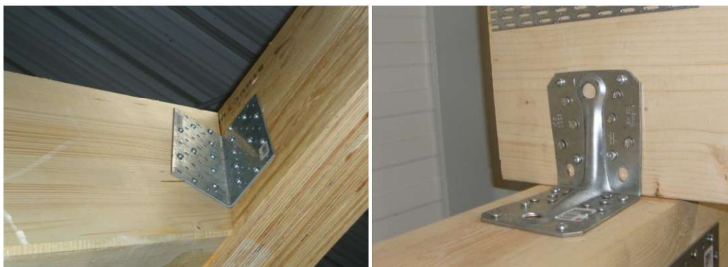
Fot. 7.25 TAK. Poprawnie wykonane połączenia z wykorzystaniem kątowników i projektowo dobranej ilości łączników. (fot. T. Szczesiak)
