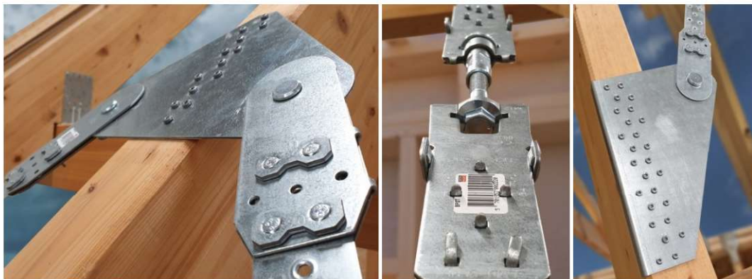
Fot. 7.23 TAK. Poprawnie wykonane detale stężeń systemowych z zastosowaniem taśmy perforowanej. Zastosowanie pokazanej na środkowym zdjęciu nakrętki napinającej pozwala na właściwe napięcie stężenia w przypadku zastosowania taśmy. (fot. T. Szczesiak)
