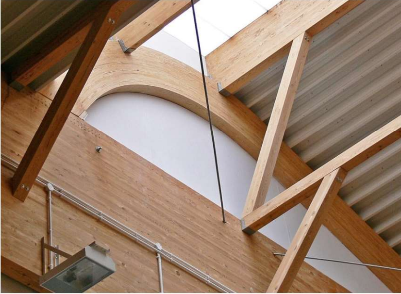
Fot. 1.3 Rozwiązanie przekrycia w kompleksie sportowym w Łomiankach (fot. P. Sulik)
