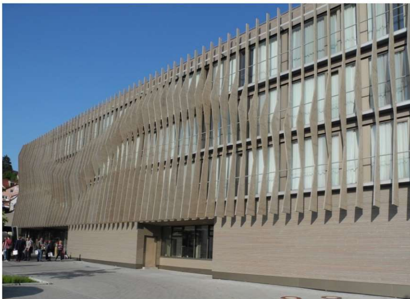
Fot. 1.3. Szkoła o konstrukcji drewnianej w Dierdorf, Niemcy (fot. P. Sulik)
