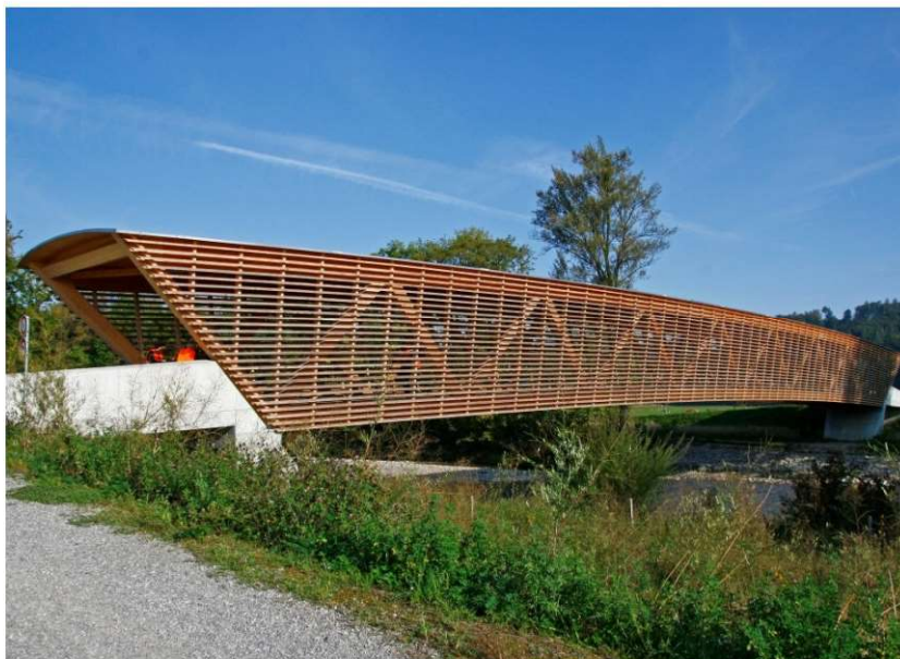
Fot. 1.24 Most Neumatt Szwajcaria. Rozpiętość 59 m (fot. E.I. Kotwica)
