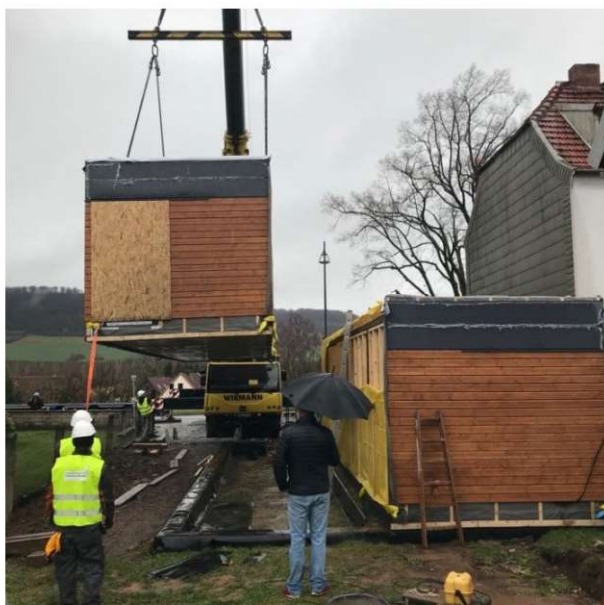
Fot. 1.11 Montaż jednorodzinnego budynku modułowego (fot B. Jaworski)
