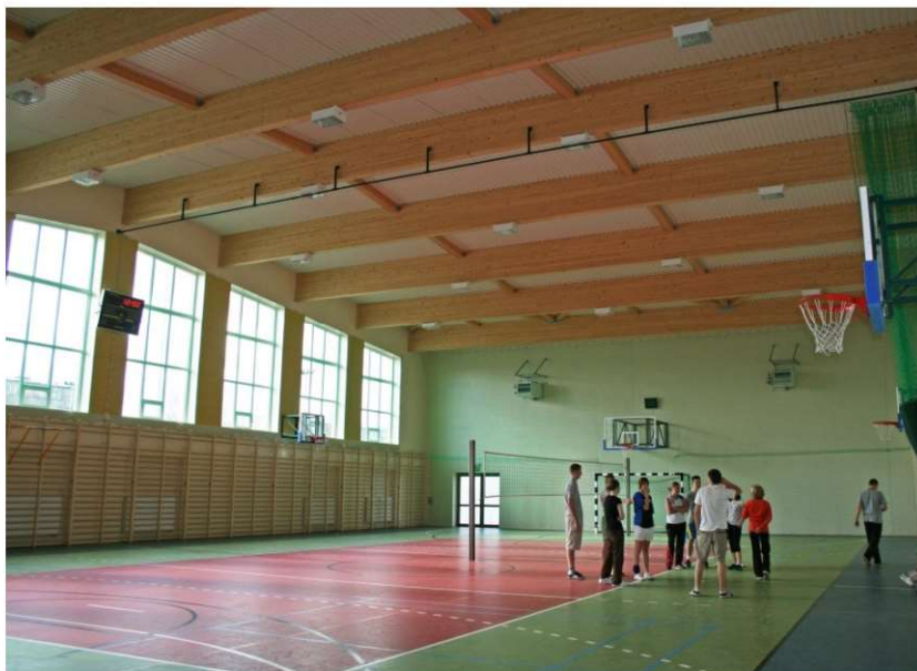
Fot. 1.22 Hala sportowa w Chojnicach, rozpiętość 21 m (fot. E.I. Kotwica)
