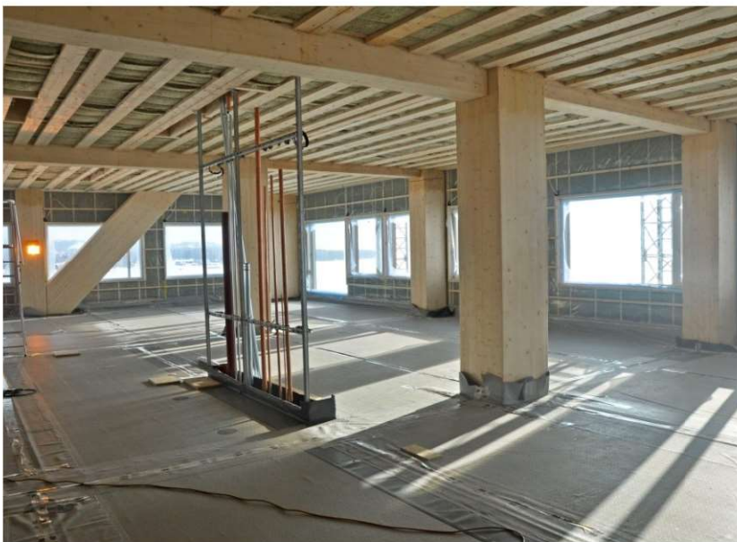
Fot. 1.7 18-kondygnacyjny budynek Mjøstårnet w Brumunddal (Norwegia) na etapie montażu (fot. T. Birgersson)
