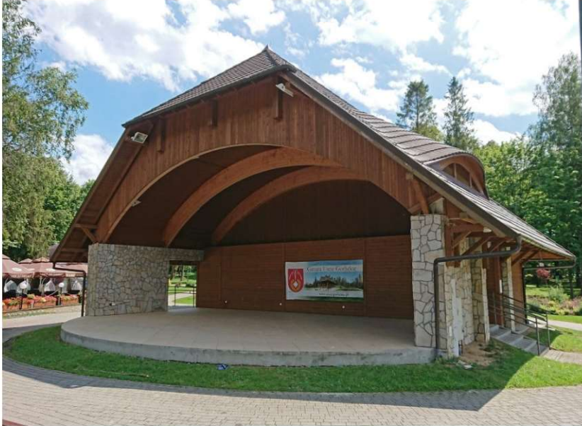
Fot. 1.20 Amfiteatr, Wysowa. Rozpiętość łuków 14,4 m (fot. E.I. Kotwica)
