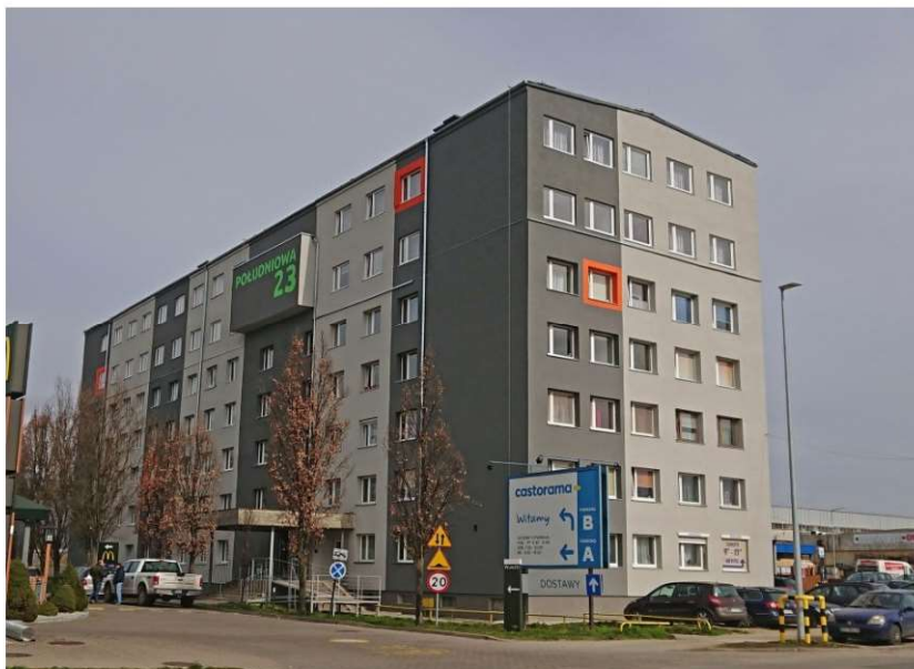
Fot. 1.18 Budynek hotelu robotniczego w Szczecinie. Dwie ostatnie kondygnacje wykonano jako nadbudowę w technologii prefabrykowanego szkieletu drewnianego (fot. E.I. Kotwica)
