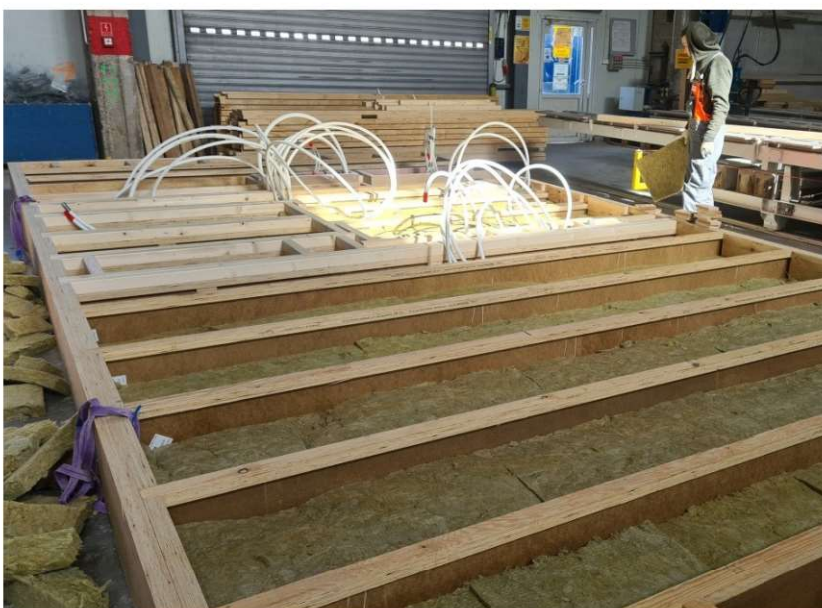
Fot. 1.8 Prefabrykacja stropu o konstrukcji szkieletowej (fot. P. Sulik)
