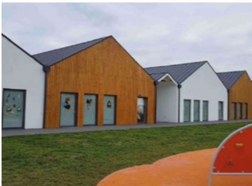
Fot. 1.19 Przedszkole wykonane w technologii prefabrykowanego szkieletu drewnianego, Gdańsk (fot. z archiwum Stowarzyszenia EDG)
